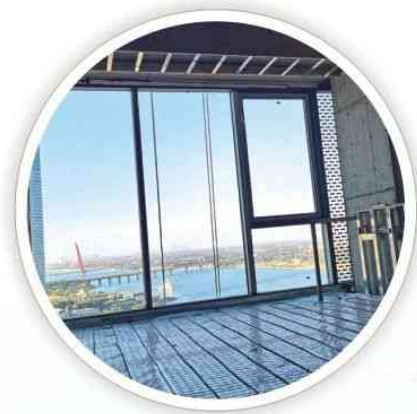
中天·江湾天地 3#楼实体样板房地暖铺设
